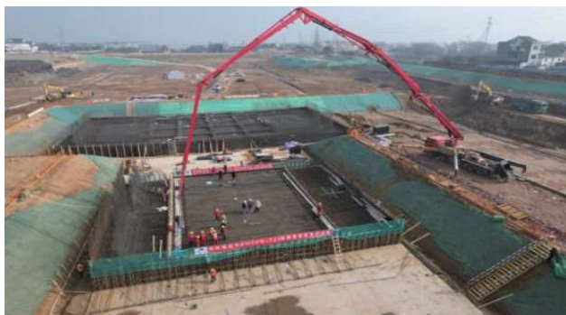
图2 闸室底板施工图示
