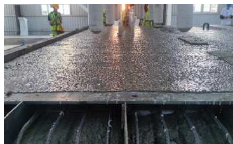
图5 混凝土振捣
