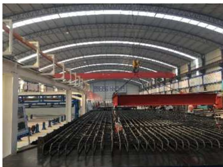
图3 钢筋骨架吊装入模
