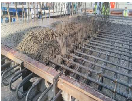
图4 混凝土浇筑
