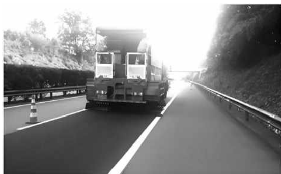
图1 高寒地区公路路面摊铺施工场景
