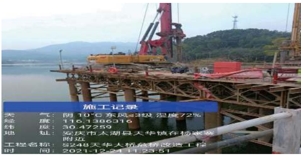
现场引孔照片
