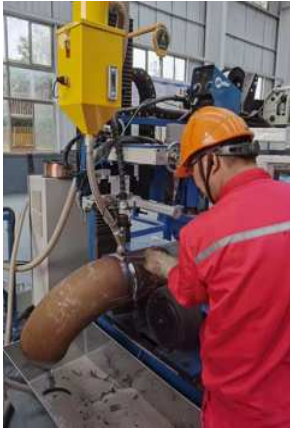
4.2.3-2 自动焊接作业线
