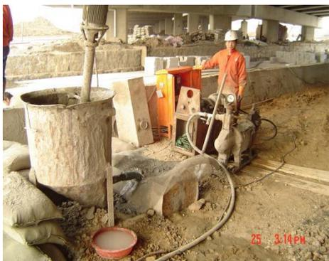
图7 压密注浆施工
