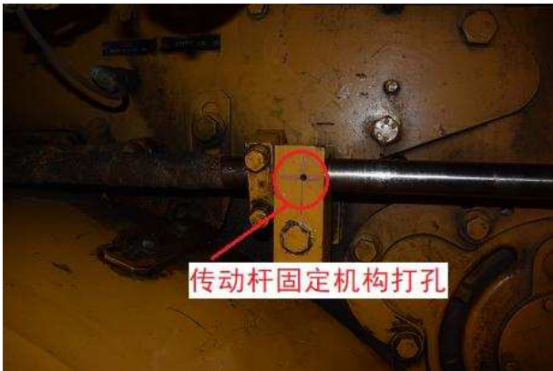
图 15 传动杆固定机构钻孔
