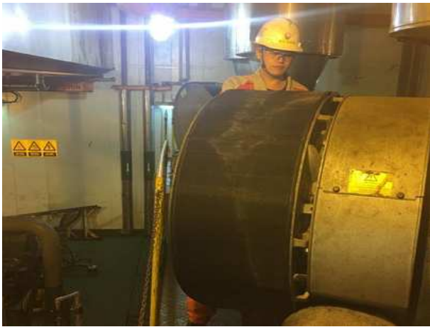
图 19 现场安装外置滤网
