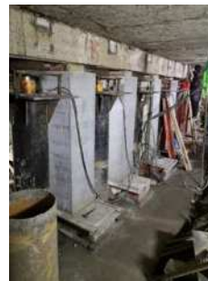
临时支撑及新做立柱
