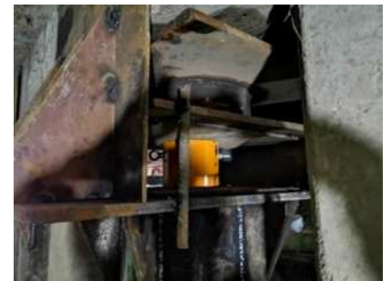
临时支撑顶部千斤顶
