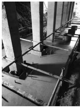
承台混凝土浇筑
