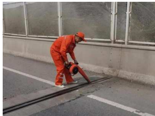
图3 公路桥梁现浇箱梁混凝土养护
