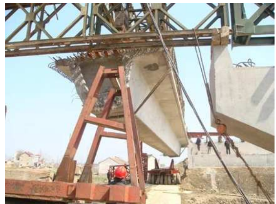
图 1 公路桥梁施工中现浇箱梁预应力施工
