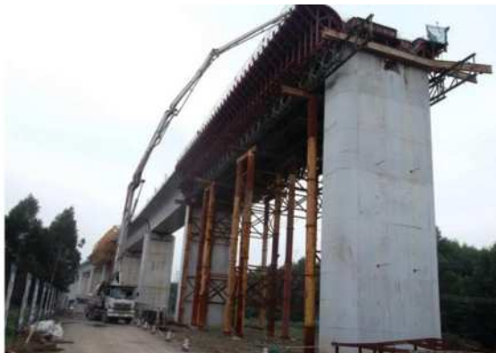
图2 公路桥梁现浇筑浇箱梁施工
