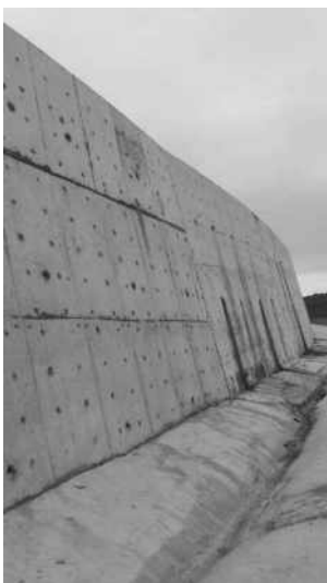
图 3-2 悬臂式挡土墙及边沟
