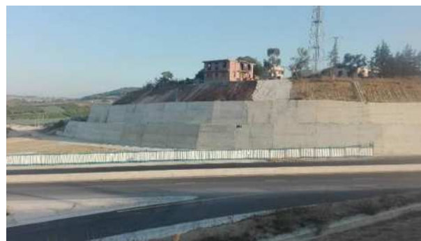
图 1-2 二级重力式挡土墙实景图
