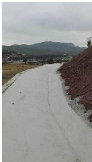
图 3-4 墙顶及坡面恢复图
