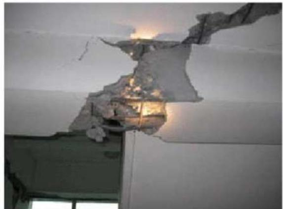
图3 框架结构梯梁剪断
