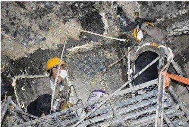
图1 隧道渗漏水病害治理
