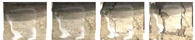
a 裂纹萌生阶段 b 裂纹拓展阶段 c 裂纹贯穿阶段 d 试件破坏
