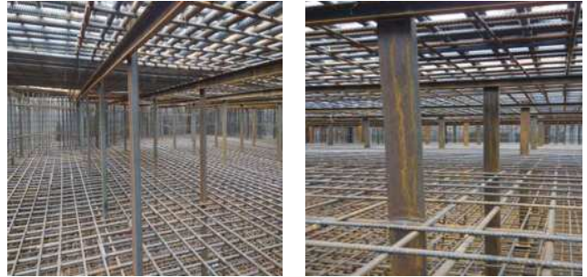
图 4 核心筒多桩承台型钢支撑安装现场图
