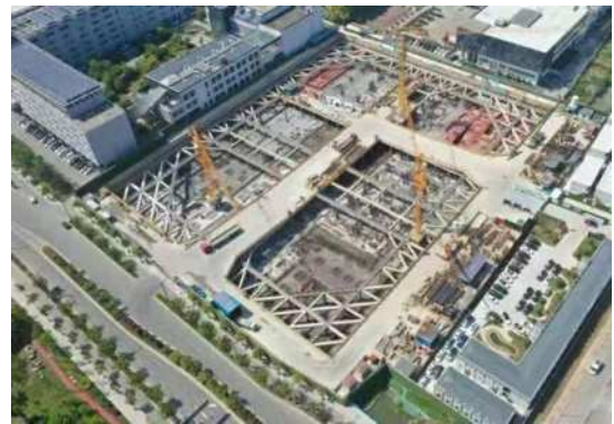
图5 基坑开挖到底现状图
