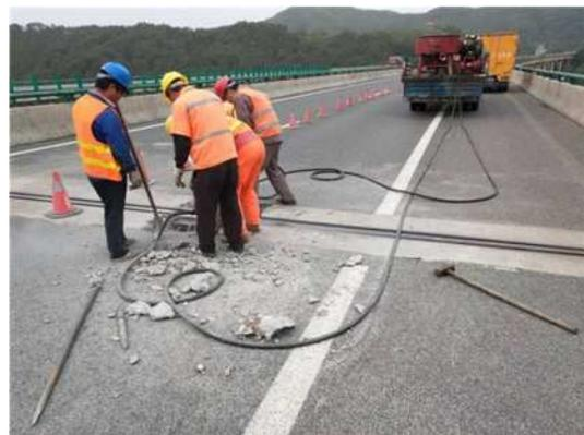
图2 开槽施工
