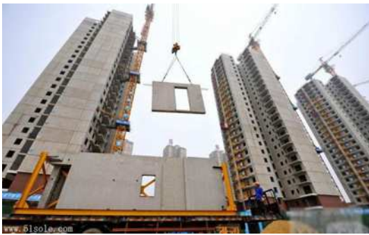
图3 构件吊装
