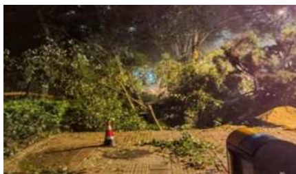
图 3 管线渗漏引发人行道地面塌陷
