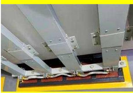
(9) 插接式封闭母线插接箱安装前,应打开插接式封闭母线插孔处的安全挡板,应先将箱内断路器推至 OFF 断开位置,将插接箱插脚按相序从插接式封闭母线插口处插入插接式封闭母线内,并保证插入到位。禁止带电插拔。插接箱安装后,应将其前后两处爪型卡板固定于插接式封闭母线两侧,并拧紧螺丝。内装大型断路器的插接箱,其垂直安装时,底部应加装承重托臂;水平安装时,应加装承重抱箍。
