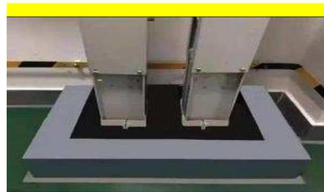
(6) 插接式封闭母线段与段连接时，两相邻段母线及外壳宜对准，相序应正确，连接后不应使插接式封闭母线及外壳受额外应力；连接方法应符合产品技术文件要求；插接式封闭母线连接用部件的防护等级应与插接式封闭母线本体的防护等级一致。
