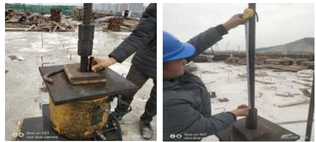
图8 精准控制吊杆下落
