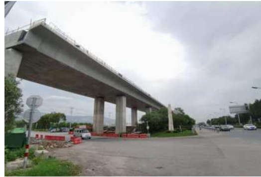
图 14 四线连续梁成品
