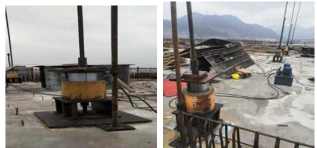
图4 落梁装置图
