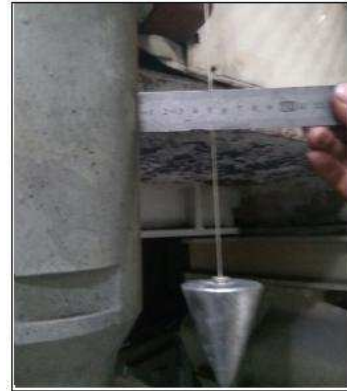
图5 拉杆垂直度测量
