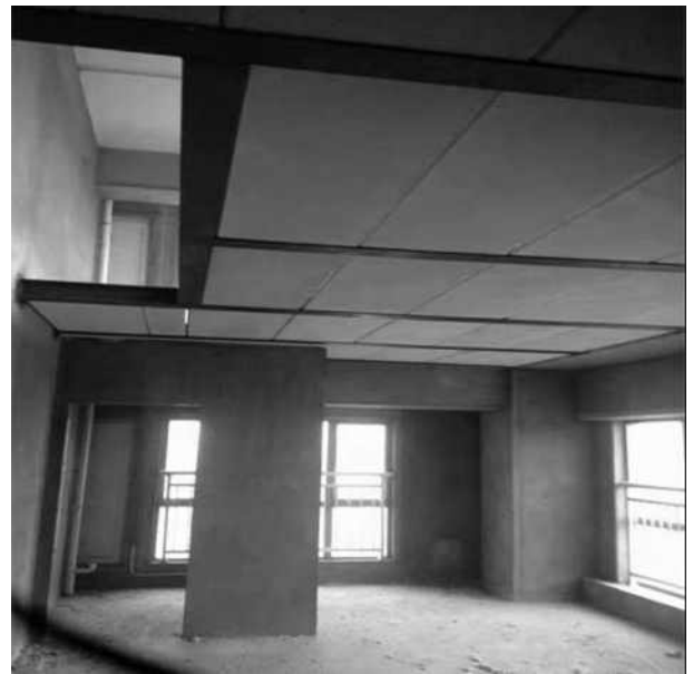
图1 装配式隔墙板在室内装饰中的应用
