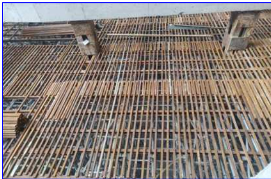
图 2-1: 脚手架平台搭设
