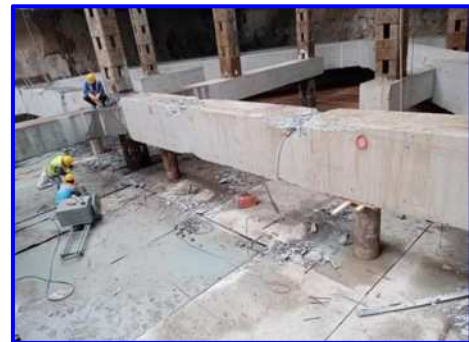
图 2-2: 钢桶支顶切割
