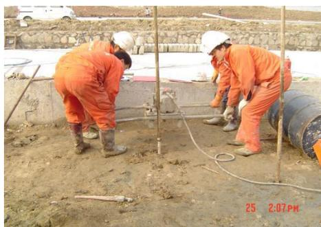
图8 压密注浆施工
