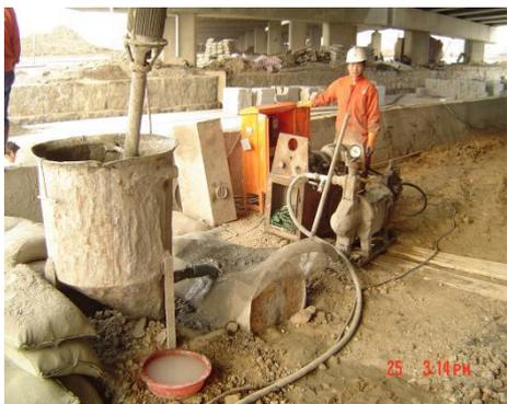
图7 压密注浆施工
