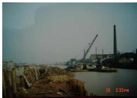
图 2 单排钢板桩围堰施工
