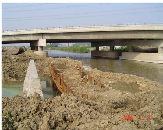
图4 土坝中打设双层钢板桩
