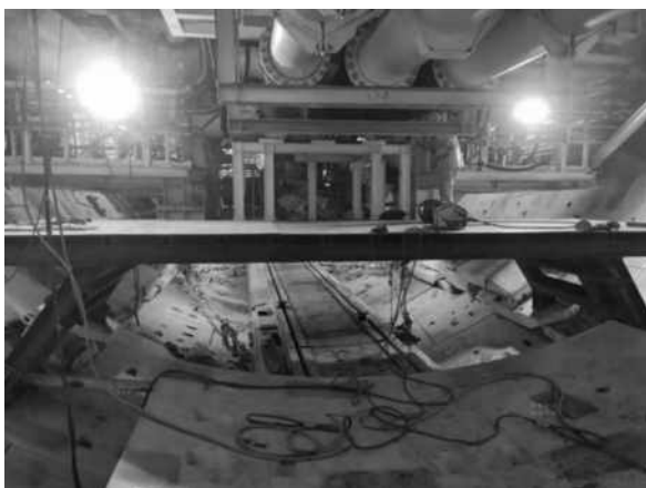
图1 安装压重平台
