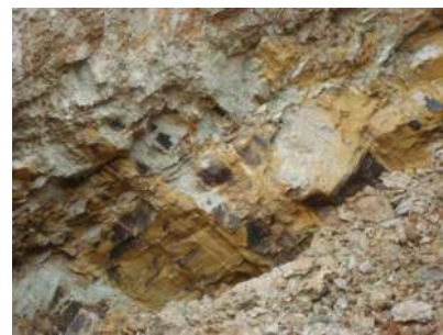
图二、冒顶后洞顶的昔格达地层
