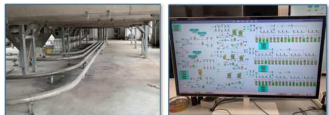
图1 现场图片、中控平台图片
