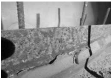
钢筋腐蚀
