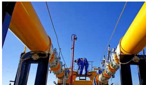
图3 天然气长输管道施工技术要点
