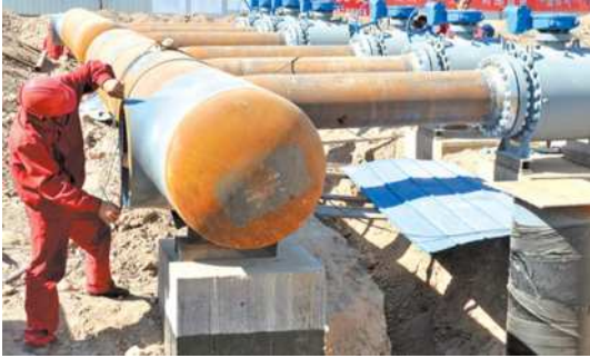
图4 油气管道施工
