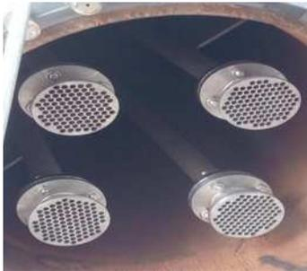
图4 侧出料煤粉管线实物图
