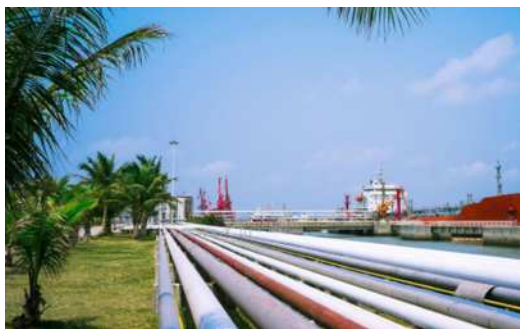
图3 油气储运管道工程
