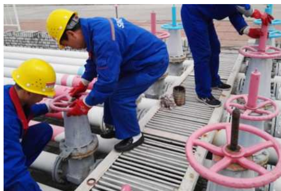
图4 储运管道施工
