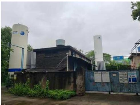
图4 全厂功能性气罐区集中布置实景图
