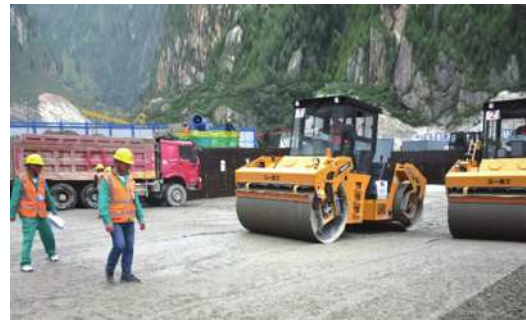
图2 某大坝混凝土碾压
