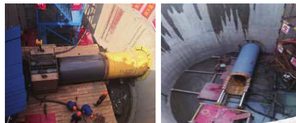
顶管机机头及正常管节顶进工作图
