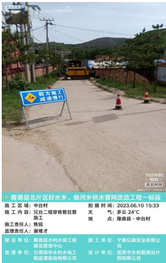
施工现场摆放施工警示标识牌
